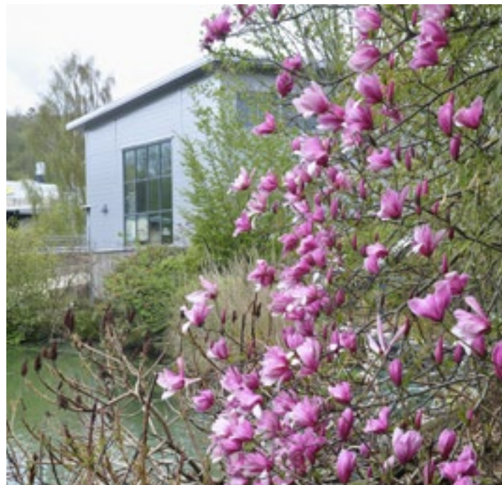
Magnolia Spectrum framför Munkedals nya vattenkraftsbyggnad
